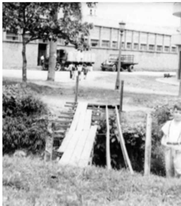
Plazuela de La República o Francisco Antonio Zea, puentes sobre la quebrada Santa Elena que comunicaban a San Benito con el barrio Estación Villa. (Fotografías FAES, sin fecha).
