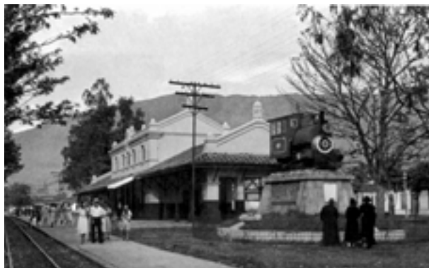
Estación Villa en 1939, nótese el esplendor del barrio y la dinámica que se genera entorno a la estación ferroviaria. (Archivo fotográfico Gabriel Carvajal)
