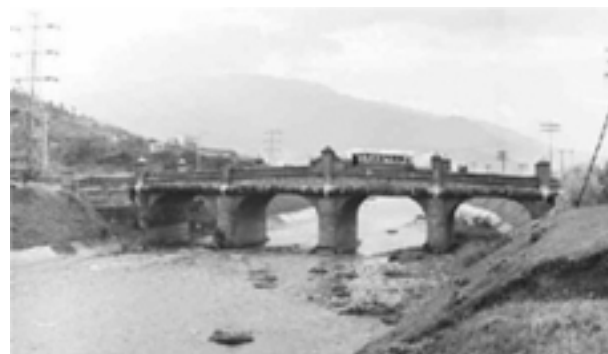
Aspecto que presentaba el puente de Guayaquil en la década de los 80.
