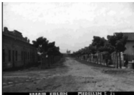
Arriba, remate de la carrera Bolívar en la estación del ferrocarril de Amagá. Abajo trazado vial del barrio Colón en 1927.
